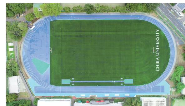
▲ 陸上グラウンドの改修状況(R6.9.30現在)
