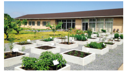
改修工事が完了した柏の葉キャンパス「薬草園」後方に見えるのが「柏の葉診療所」
