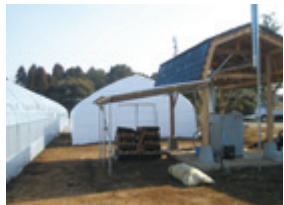
園芸用ハウスに設置した暖房機(右端)と燃料用丸太(正面)平成25年度は10基、26年度は更に16基を設置の予定です。
